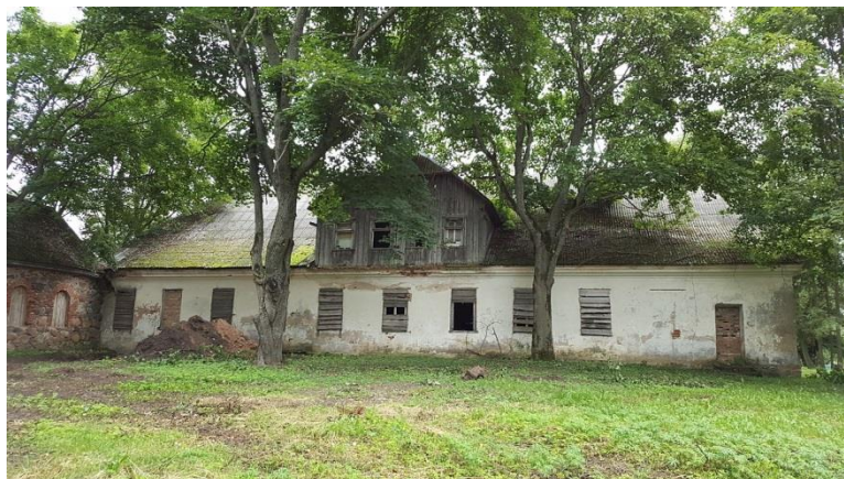
16 pav. Bukonių dvaro sodyba ( http://kvr.kpd.lt/heritage )
